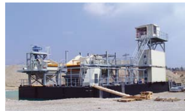
Aufbau des Schwimmbaggers im noch kleinen See.
