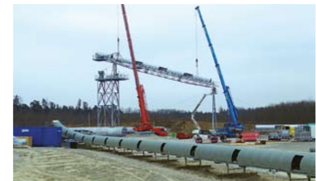
Autokräne setzen das Förderband an Ort und Stelle.
